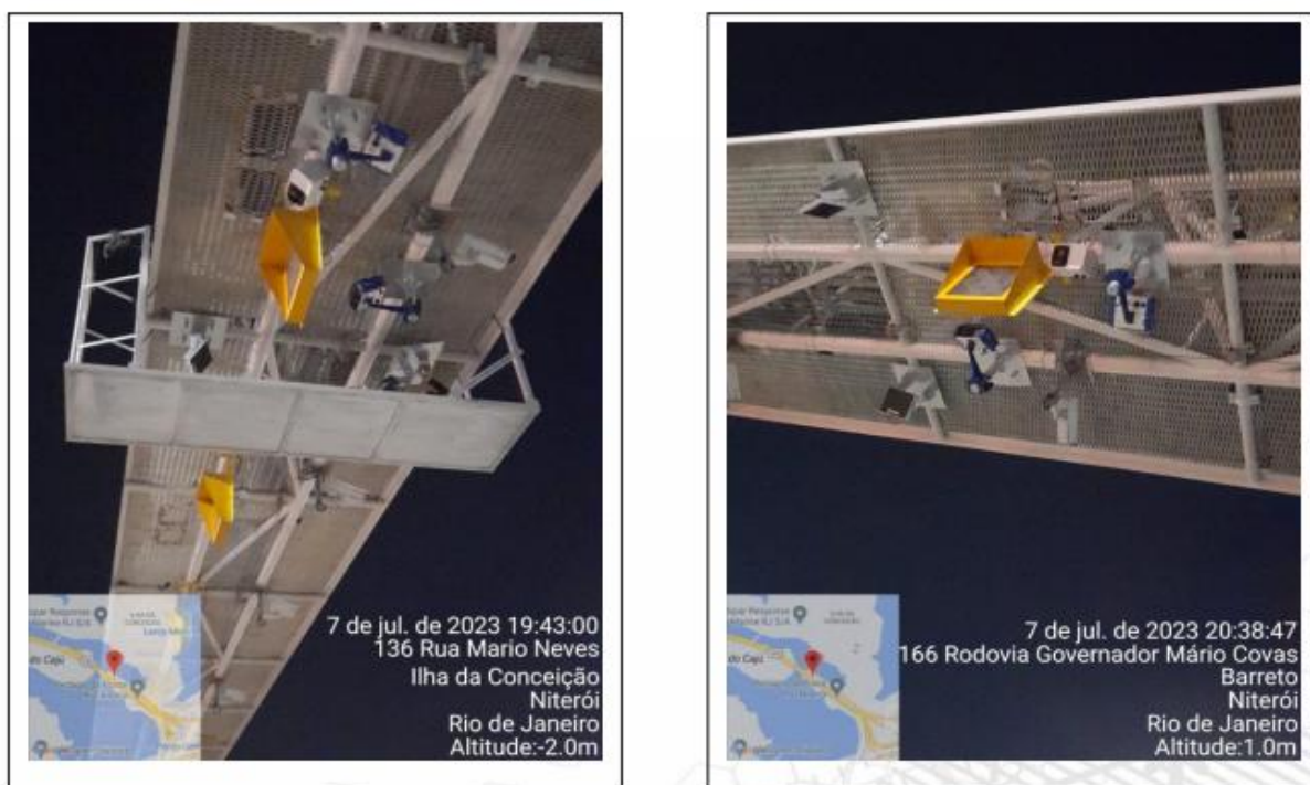
Figura 2 – Disposição dos equipamentos
